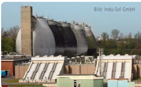
Bild 2: Im linken Bildteil sind die Faulbehälter, so genannte Eier, zu sehen. Der rechte Bildteil zeigt vier Zwischenklärbecken, sowie den Abwasserfilter oder auch Sandfilter (rechts) und die zweite biologische Reinigungsstufe (links).
