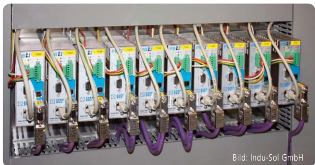
Bild 5: Bei der Stadtentwässerung und Umweltanalytik Nürnberg sind zehn Profibus-Inspektoren von Indu-Sol fest installiert.
