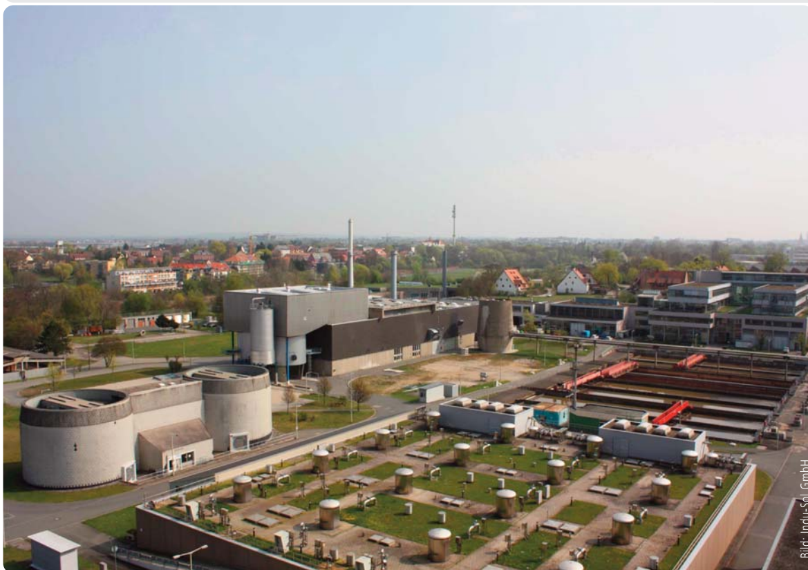
Bild 1: Die komplette Anlage mit sauerstoffbegaster Hochlastbelebungsstufe (vorne), Vorklärbecken (rechts), Werkstätten und Verwaltung (hinten), Blockheizkraftwerken und mechanischer Schlammwässerung (links) und Überschussschlammverdicker (links außen).
